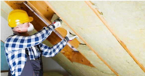
Pour isoler le grenier, on peut choisir d'isoler le toit ou le plancher.
